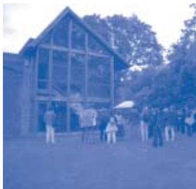
La verrière du pignon sud-est des écuries permet de profiter au mieux des apports solaires.
