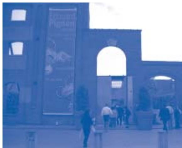
L'entrée du musée se fait par cette ancienne façade d'usine percée de baies.
